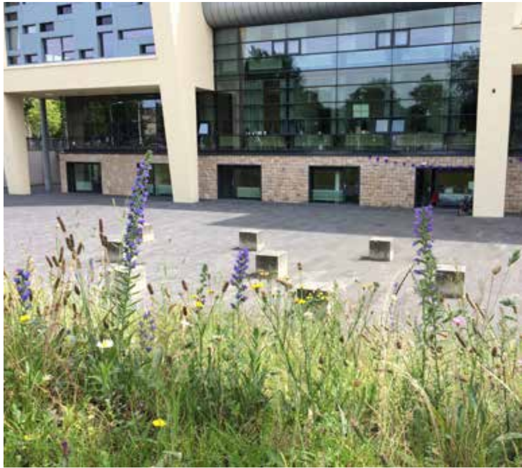
Talud Elinor Ostromgebouw
